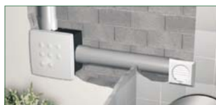
Obr. 4 - Odsávanie z dvoch miestností súčasne (napr. WC a kúpeľňa)
